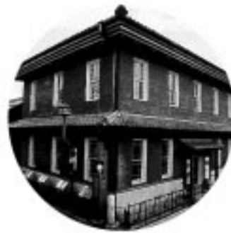
黒壁ガラス館【1号館】
